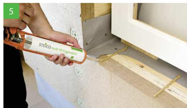
5 multi fill au niveau de l'appui. L'espacement maximal des cordons de mastic-colle est de 30 cm.
