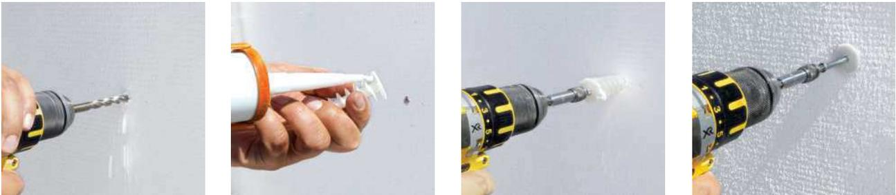
De faibles charges comme une lampe ou une boîte aux lettres peuvent être fixées dans l'isolant avec des chevilles à isolant. Le trou pour les chevilles spirales doit être prépercé avec une mèche à bois de diamètre 8 mm. Le montage doit être effectué sans risque d'infiltration d'eau dans l'isolant. Il est recommandé d'utiliser une bande d'étanchéité et un mastic-colle élastique pour assurer l'étanchéité des joints.
