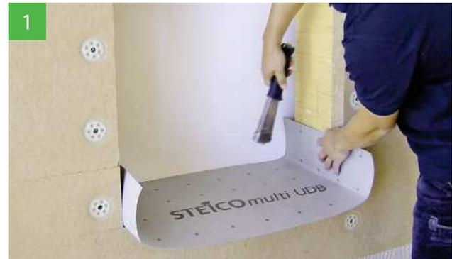
1 multi UDB pour protéger la construction des intempéries.
